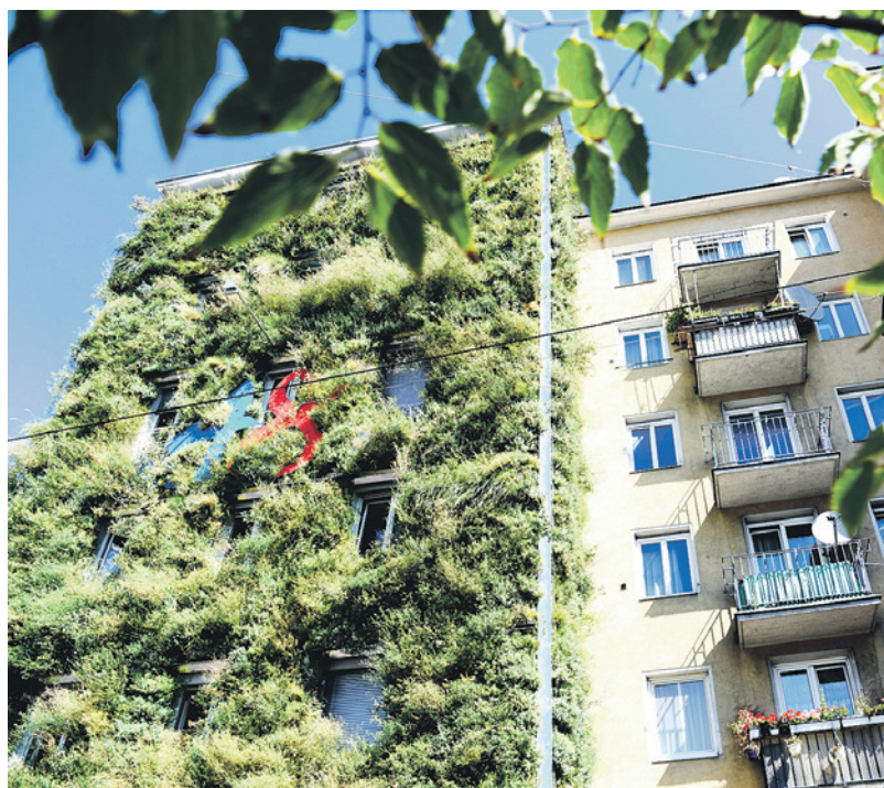
Die grünen Fassaden des MA-48-Bürogebäudes am Margaretengürtel kühlen an Hitzetagen so stark wie 75 Klimageräte mit 3000 Watt Leistung und acht Stunden Betriebsdauer
