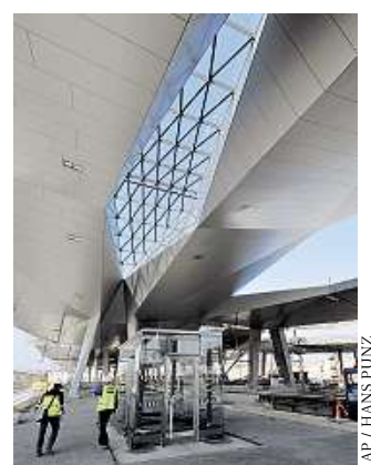
Wie Raumschiffe: Die ersten acht Rautendächer sind fast fertig
